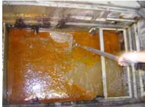
角型アミで投入した油吸着材をすぐに回収します。
