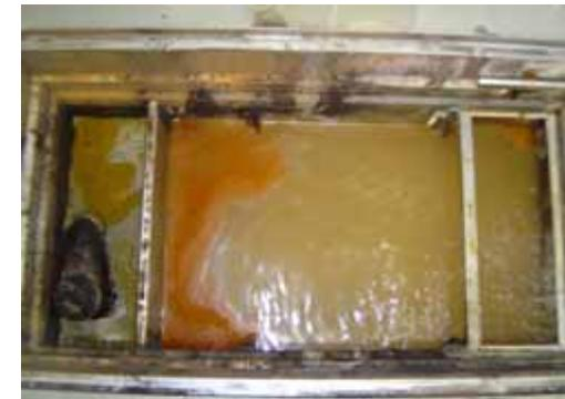
油吸着材は水を吸わないので浮上油のみを簡単に回収できます。
